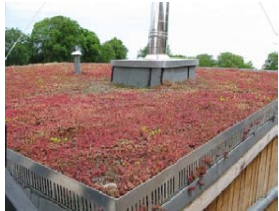
toiture végétalisée, Lille - couturenovationtoiture
