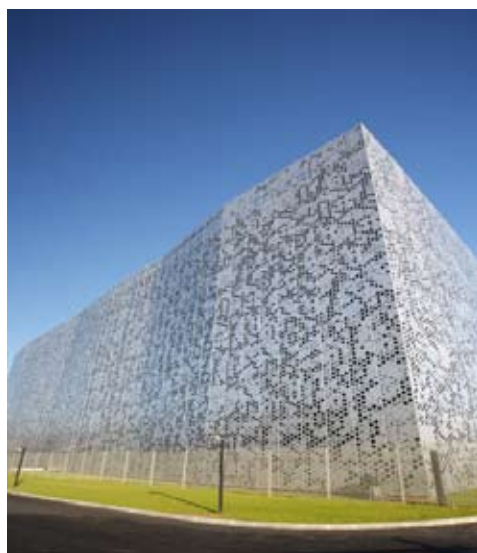
Bâtiment des archives du Nord à énergie positive, Lille - Batweb
